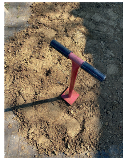
Abb. 4.: Aufbereitung der befeuchteten Lehmplatten, zerstampfen und zerhacken des Ausgangsmaterials.
