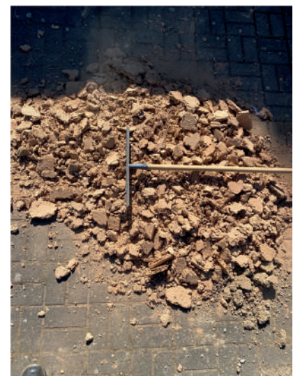
Abb. 3.: Aufbereitung der befeuchteten Lehmplatten, zerstampfen und zerhacken des Ausgangsmaterials.
