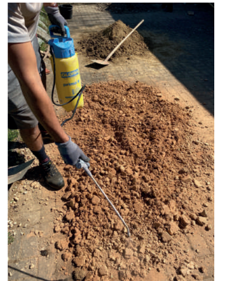
Abb. 2.: Befeuchtung des Materials, damit dieser leichter verarbeitet werden kann. Sammlung aus vorherigen Bauphasen – Wiederverwendung von Stampflehm
