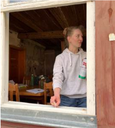
Abb. 9: Behandlung des Fensterbeschlags mit Pflegemittel
