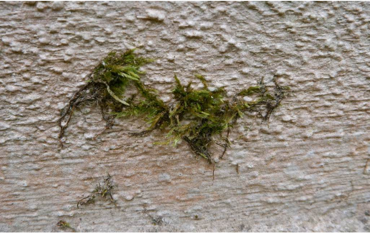
Abb. 2, 3: Flechten und Moose in der Sockelzone des Hauses
