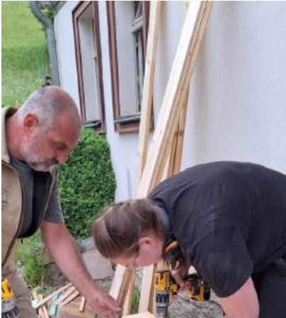
Abb. 19: Entfernung des Holzbalkens
