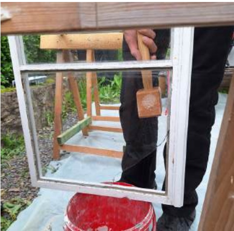
Abb. 9: Entfernen der alten Glasscheibe
