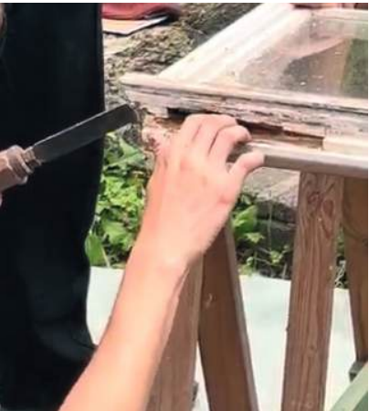
30: Entfernung beschädigter Elemente des Fensterrahmens
