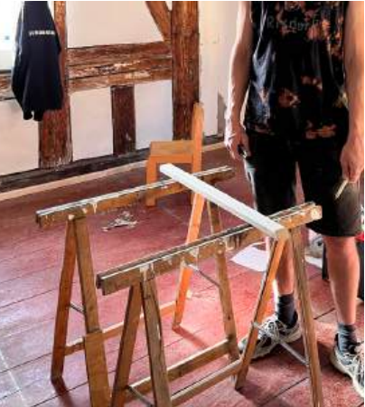
Abb. 25: Zuschnitt der Kanthölzer
