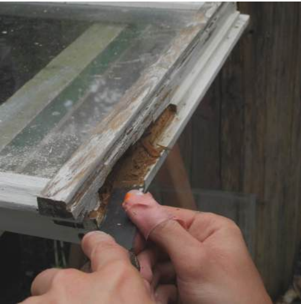
Abb. 7: Fäulnis unter dem Wetterschenkel
