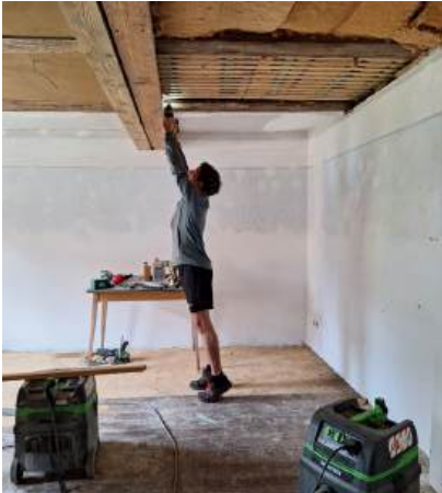
Abb. 13: Befestigung der Holzlatten auf der Dämmung
