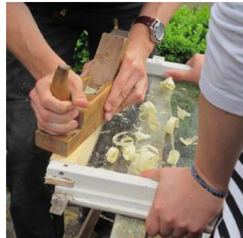
Abb. 7: Passtück plan hobeln
