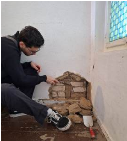
Abb. 10: Entfernung von schadhaftem Putz
