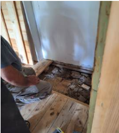
Abb. 20: Anfertigung eines herausnehmbaren Holzelements
