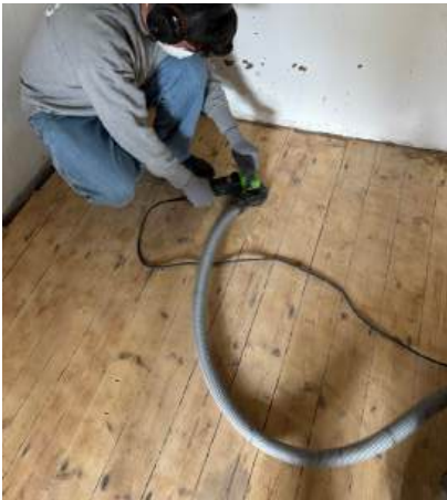
Abb. 5: Abschleifen von Holzdielen
