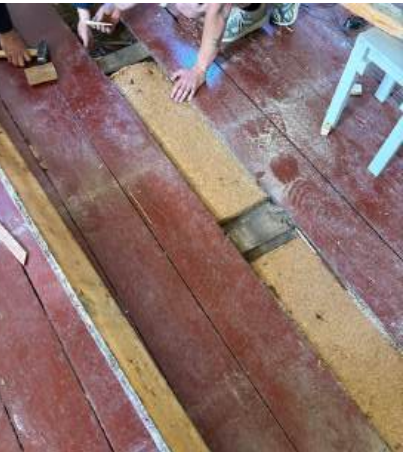
Abb. 24: Anfertigung der Kanthölzer
