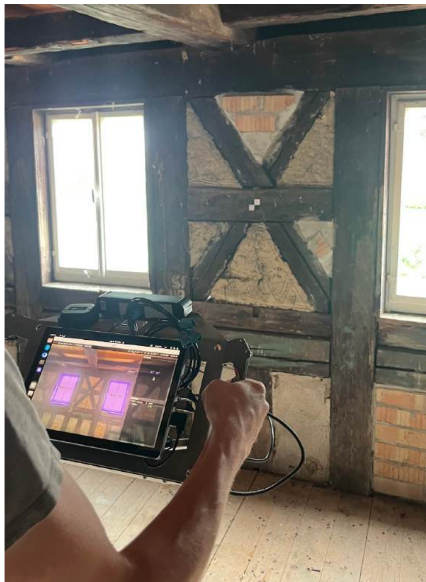
Abb. 1: Vor-Ort-Test des tragbaren Prototyps zur Bauteilerfassung und -inventarisierung im Haus Döschnitz.
