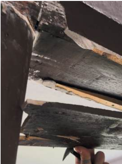
Abb. 6: Demontage der „Verkleidung“
