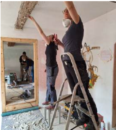
Abb. 2: Nägel aus einem Holzbalken entfernen
