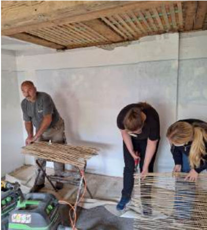
Abb. 14: Schilfrohmatten zuschneiden
