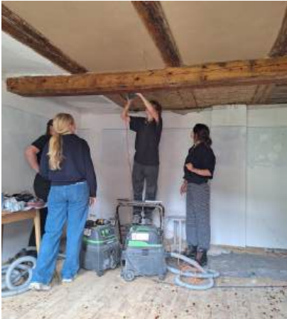
Abb. 15: Schilfrohmatten anbringen
