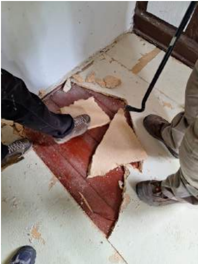
Abb. 3: die auf den Dielen montierten Bodenplatten werden entfernt
