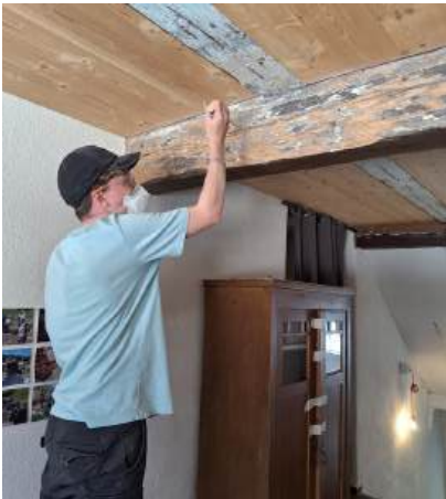
Abb. 3: Mechanische Entfernung von Putz
