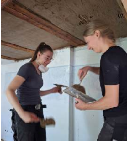
Abb. 17: Decke mit Lehmputz verputzen
