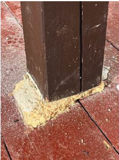
Abb. 5: Fußausbildung des im Raum, frei stehenden Stieles auf ehemaliger Bodenplatte
