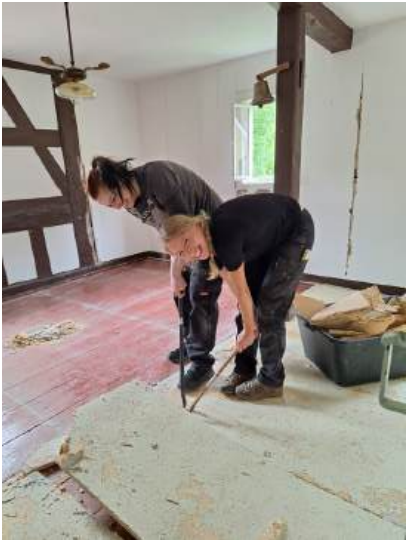
Abb. 4: Demontage der Bodenplatten im Prozess
