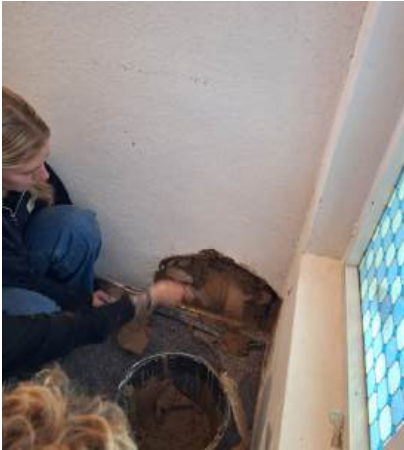
Abb. 11: Aufbringen von Lehmputz nach dem Wässern
