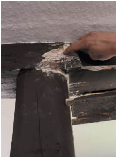
Abb. 7: Hinweise auf Trennung des Verbundes
