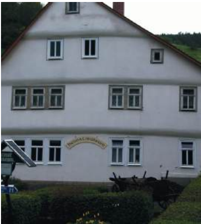
Abb. 26: Haus Döschnitz – Foto aus der bauhistorischen Untersuchung
