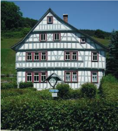
Abb. 27: Haus Döschnitz nach der Freilegung historischer Fassadenbereiche
