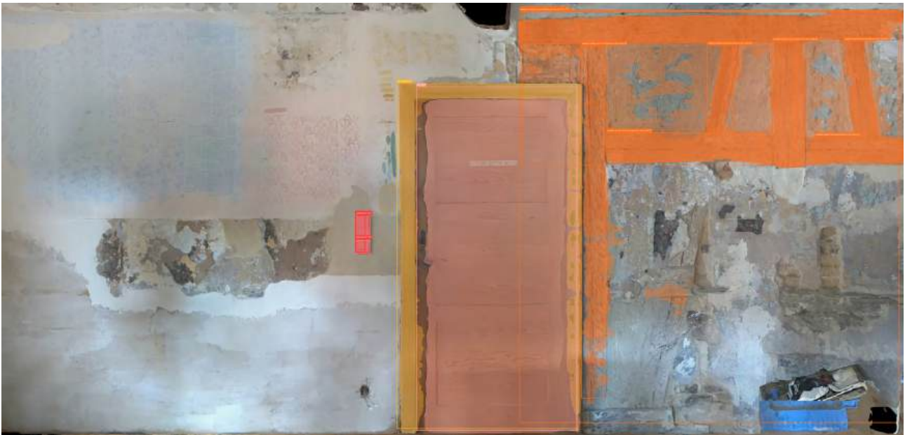
Abb. 3: Visualisierung der Ergebnisse eines Objekterkennungsmodells auf einer orthografischen Wanddarstellung der Wand im Gemeinschaftsraum von Haus Döschnitz. Erkant werden neben Türen und Elektronikbauteile auch Teile der Primärkonstruktion.
