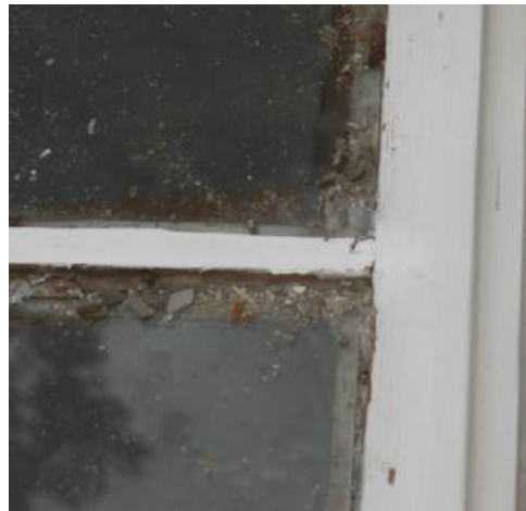
Abb. 4: Glaserdreiecke im Kittfalz
