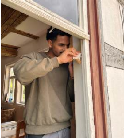
Abb. 8: Reinigung des Fensterbeschlags
