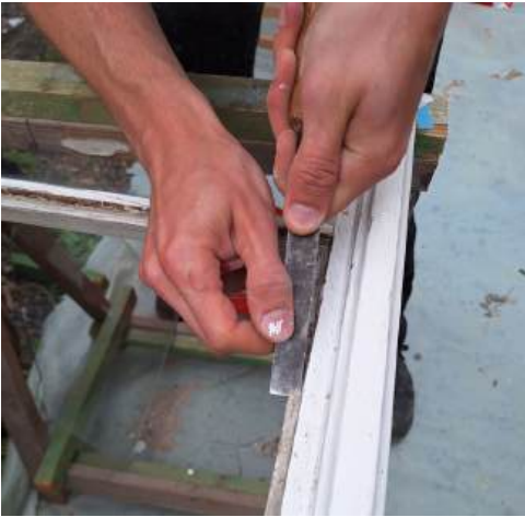
Abb. 10: Freilegen vom Glasfalz
