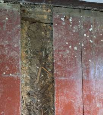
Abb. 23: Fußbodenuntersuchung: Freilegung der Dielenkonstruktion
