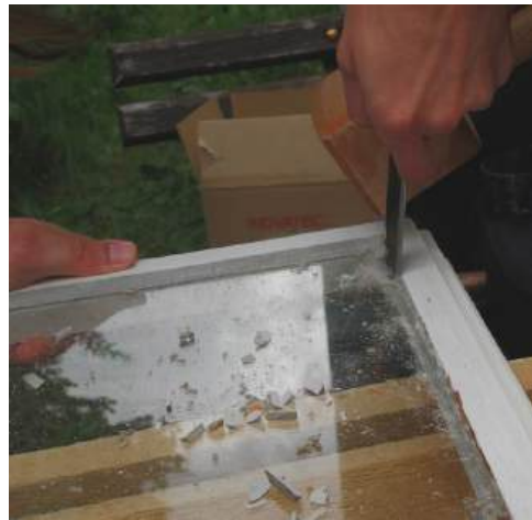
Abb. 3: Kitt entfernen
