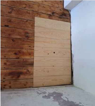
Abb. 21: Einsetzen des Holzelementes
