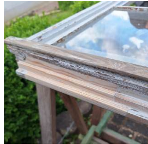
Abb. 8: Passtück mit fertigen Fälen
